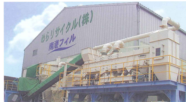
和歌山県 和歌山市 M社 混合廃棄物選別装置
