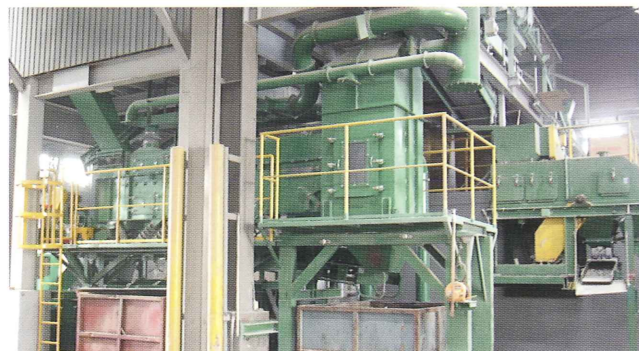
兵庫県 神戸市 O社 建設廃材選別装置
